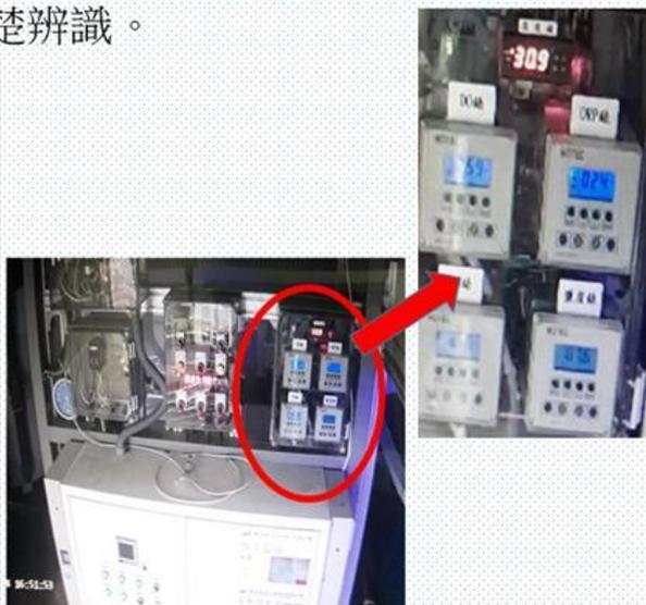
圖 4：新監控系統建置完後，各項養殖系統監控數據可以清晰在遠端讀取辨識。
